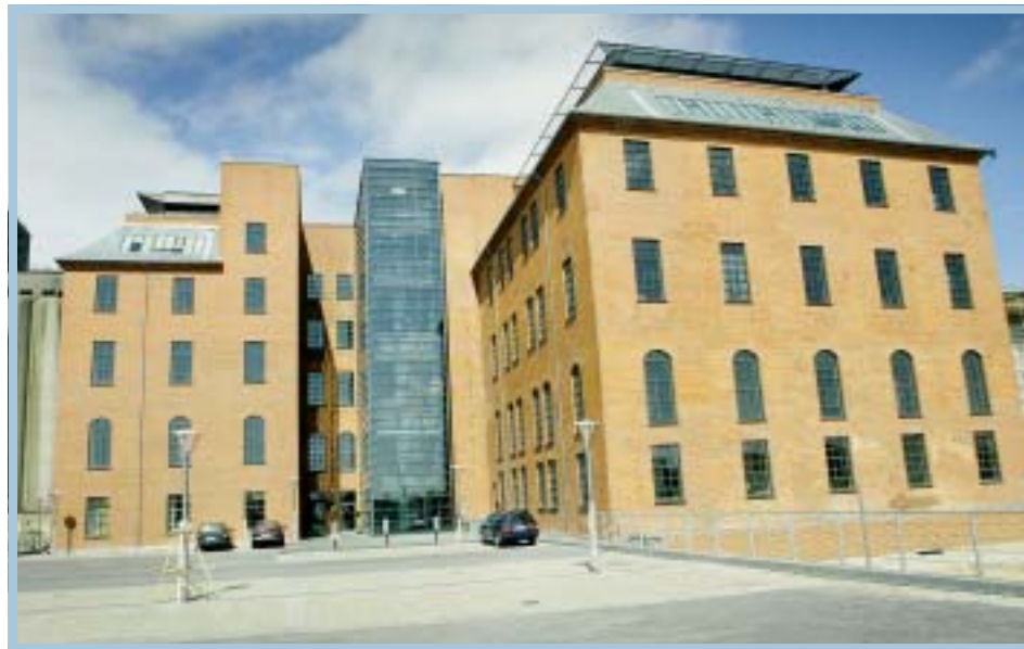
▲ Indgangen til Sundhedsstyrelsen fotograferet fra parkerings-pladsen.
